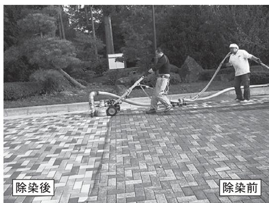
図6. 超高圧水による除染
