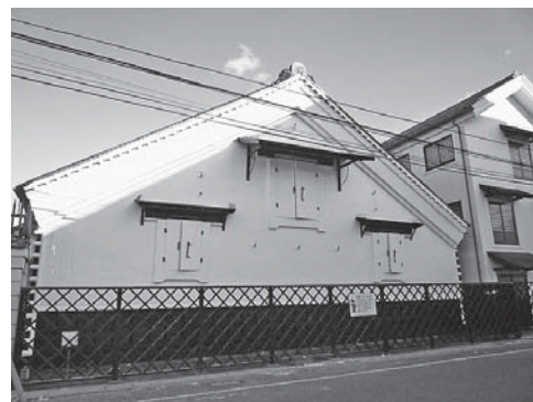
写真2 弊社仕込蔵の外観 修繕後
