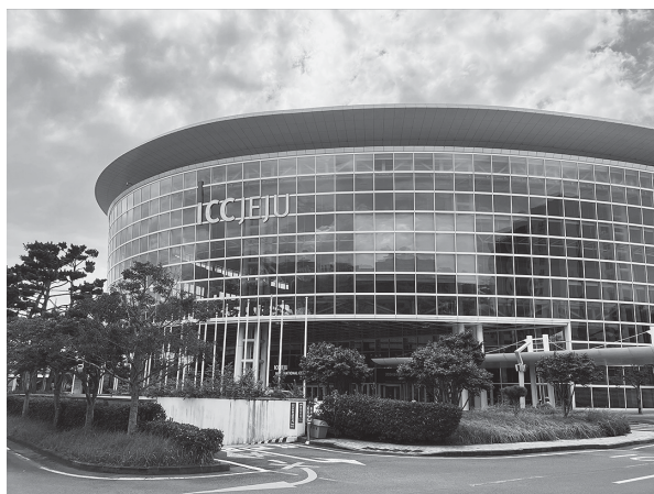
済州島国際コンベンションセンター (ICC)
